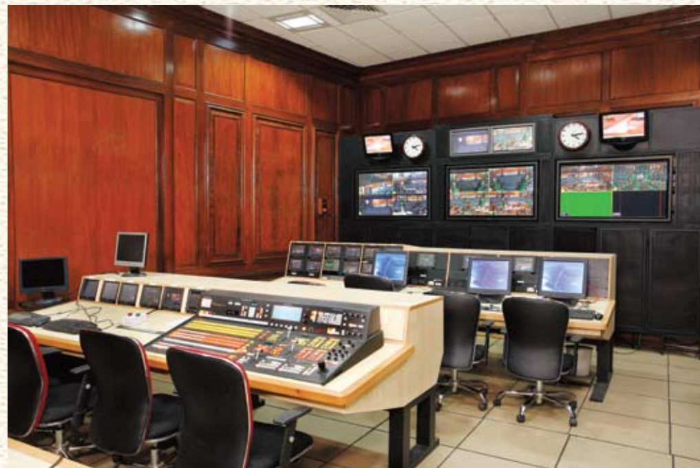
▲ संसद भवन में लोक सभा टेलीविजन का कार्यक्रम निर्माण नियंत्रण कक्ष
